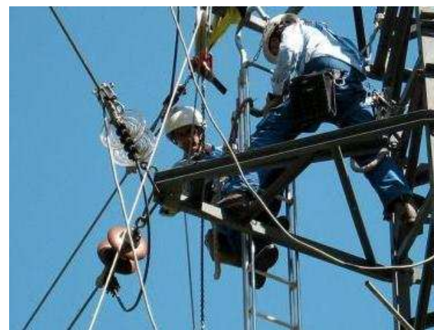
Tralici linee elettriche aeree
