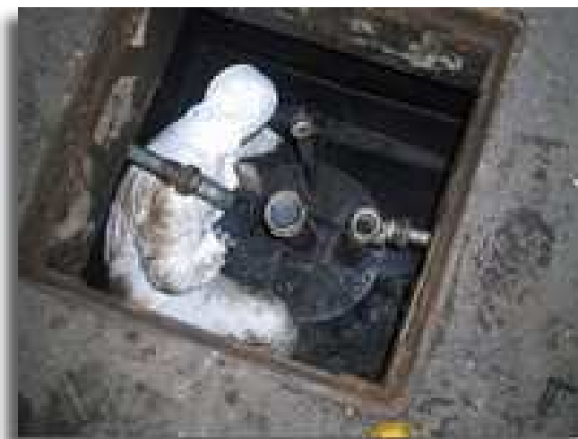
Pozzetti ingresso cisterne interrato
