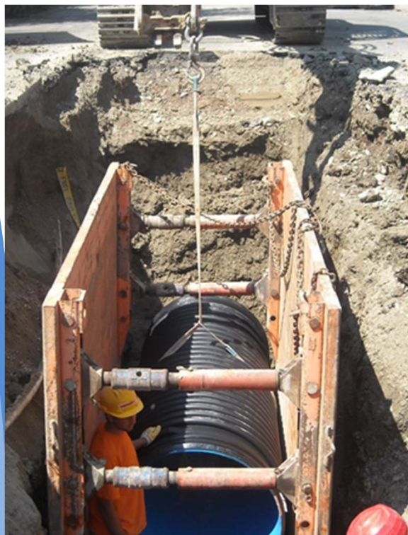
SCAVO IN TRINCEA
