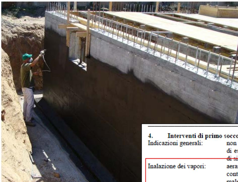
Impermeabilizzazione mura di fondazione - L'impermeabilizzante bituminoso è stato applicato mediante airless direttamente sul supporto in calcestruzzo delle mura di fondazione
