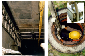
Bild 8: Steigleiter mit Seitenholmen, Steigschutzeinrichtung und Podest
