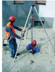
Abbildung 25: Zugungsverfahren mittels Aufzugkarrt und Rettungswinde
